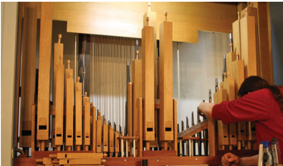
Einbau der überarbeiteten Holzpfeifen in das Brustwerk
