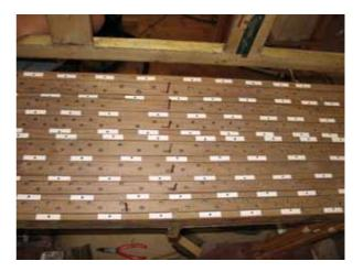
Einige Schleifen waren seitlich eingesägt worden, um ihnen die Spannung zu nehmen. Dadurch waren sie an diesen Stellen sehr labil. Sie wurden genutet und durch Einsetzen neuer, hölzerner Federn wieder stabilisiert.
