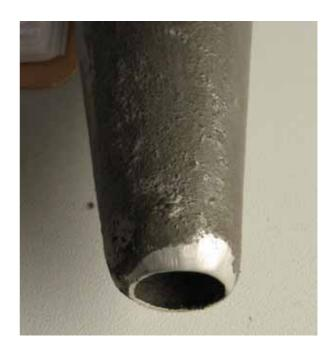
Bis auf eine Prospektpfeife (Ton h) sind alle anderen Pfeifen in der Mitte, etwa in Höhe des Rasters, aufgetrennt und neu verlötet worden. Vermutlich waren die Pfeifen dort durch Einwirkung des Holzes korrodiert und das Material mußte dort erneuert werden. Diese Einlötungen wurden, obwohl sie nicht sehr gut gemacht sind, beibehalten.
